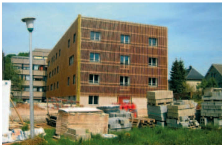
Le chantier est arrêté depuis le début de l'hiver ■ O.T.
